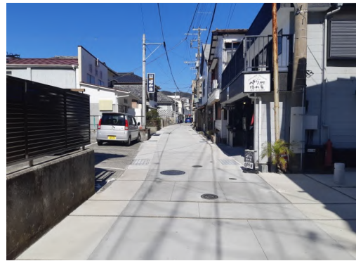
施工後 (市道大工町川岸通線完了)
