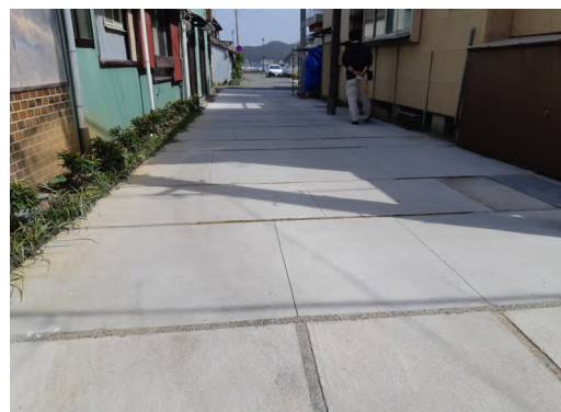
施工後 (市道大工町下川岸通線一部完了)
