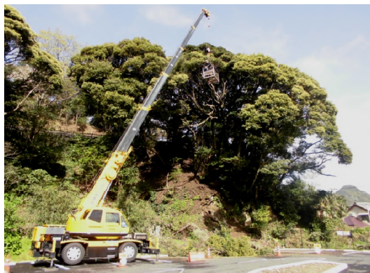
下田公園内の木の伐倒
